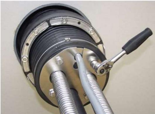
Verschraubungen nach und nach über Kreuz bis zum Anschlag anziehen.
