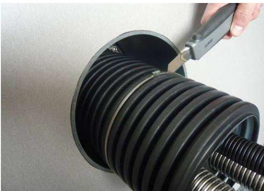
Als Abschneidhilfe für das Mantelrohr kann ein Stützring verwendet werden. Dazu wird dieser an der gewünschten Abschnittsstelle in das Wellental eingelegt. Der Stützring dient als Führung für die Messerklinge.
