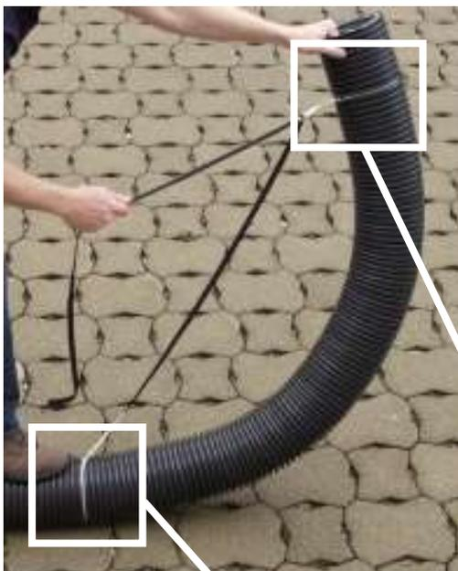
Die Bogenhaltehilfe wird wie in den Abbildungen gezeigt am Mantelrohr angebracht. Dabei werden die beiden Gurte als doppelt gelegte Schlaufen an der gewünschten Biegestelle in einem Abstand von ca. 1,5 m zueinander in die Wellentäler eingelegt und mit dem Leiterschleifer miteinander verbunden.
